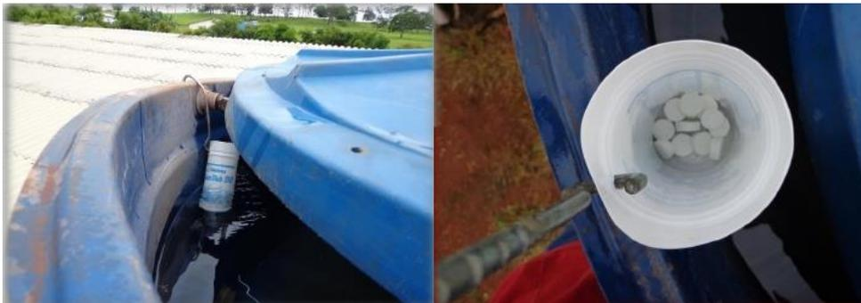
Figura 1: Cloração da água na entrada do reservatório.
